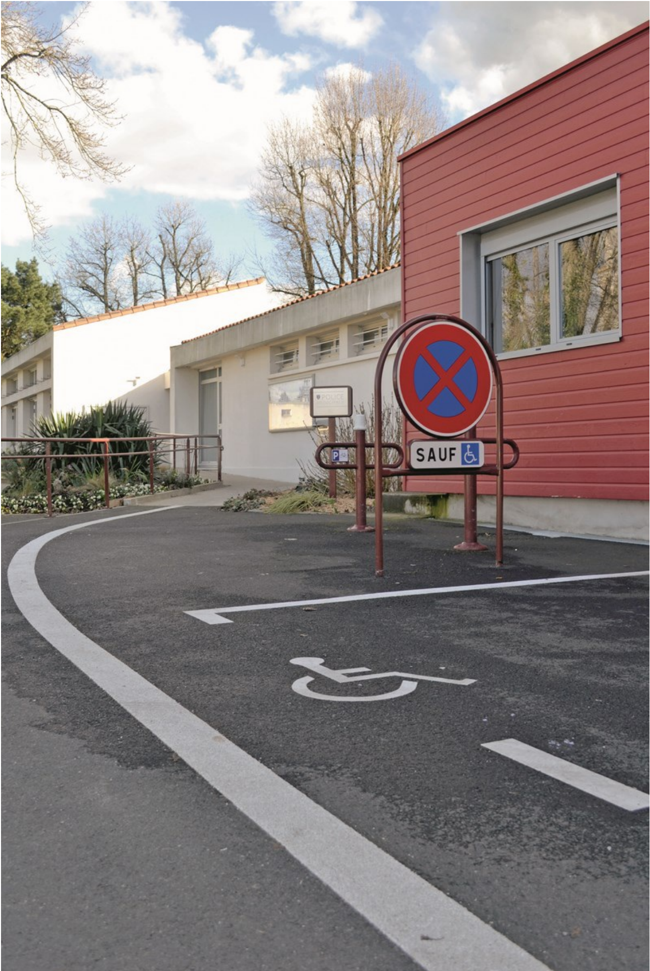
Constituent des établissements recevant du public [ERP] "tous bâtiments, locaux et enceintes dans lesquels des
