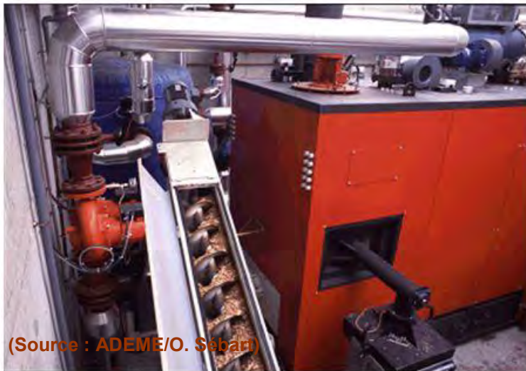
Arrivée du bois combustible dans une chaudière
