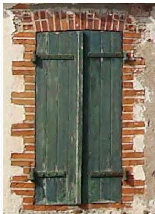
Encadrement en briques pour les ouvertures et cheminées
