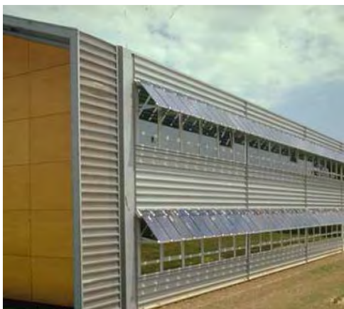
Modules intégrés avec fonction de protection solaire en forme de tuile
