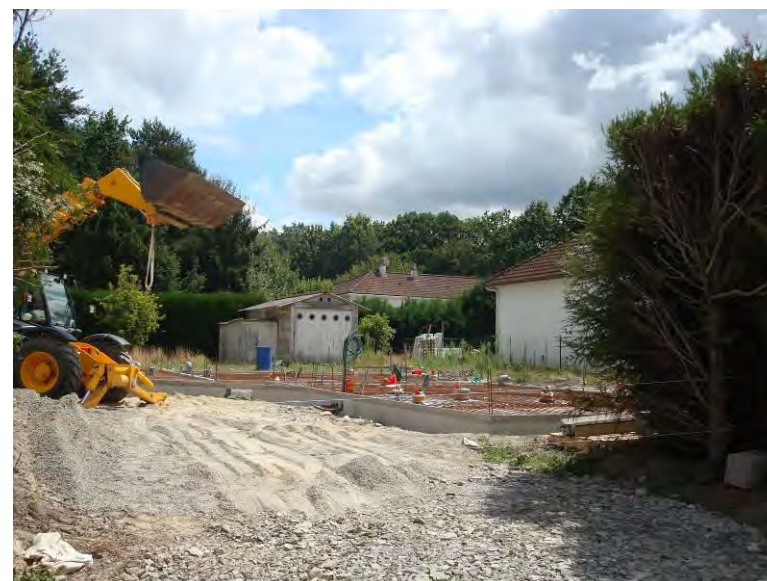
De nombreuses constructions nouvelles dans les villages (crédit photo Citadia juillet 2010)
