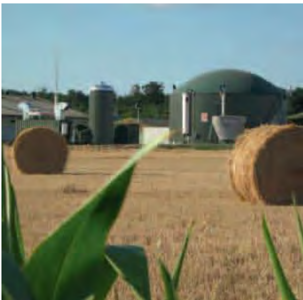
Exemple d'une structure de méthanisation (source : guide pratique de la méthanisation à la ferme www.ADEME.fr )
