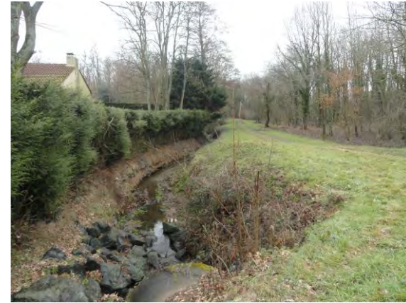
Vue sur le ruisseau et l'entrée de la buse sous la rue de Bretagne
