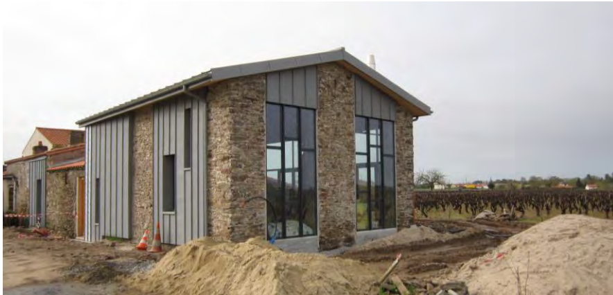
Exemple de changement de destination d'un bâtiment agricole à la Bigotière
