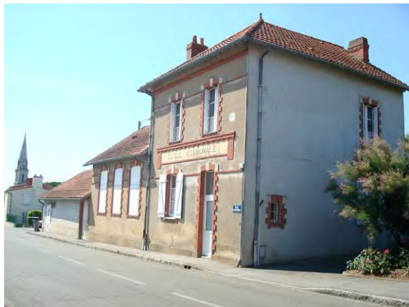
Vue sur l'ancienne école – Rue du Château
