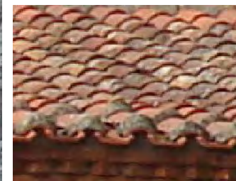
Couverture en tuiles dans l'habitat rural traditionnel
